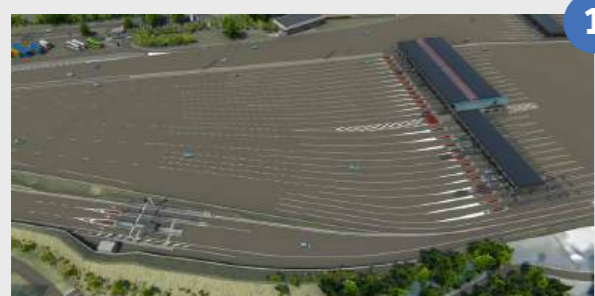
Bretelle d'entrée dans le sens Marseille - Lyon
